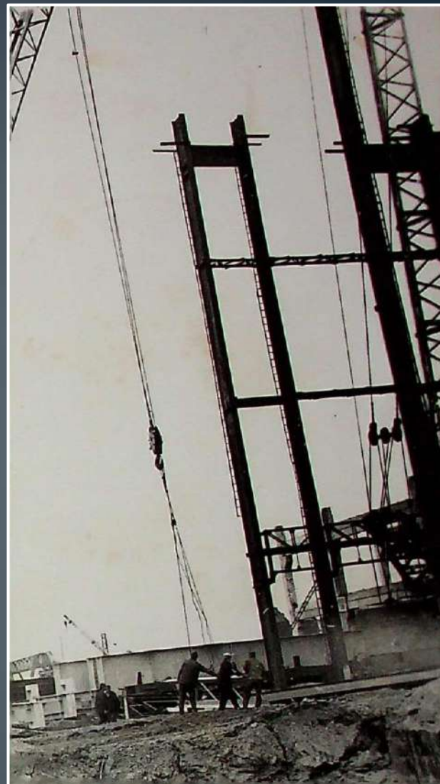
Алтайский коксохимический завод. Идет монтаж установки сухого тушения кокса. 1986 год.
